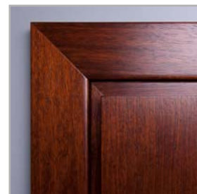
spojování lišt pod úhlem 45°
