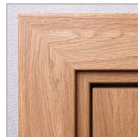
standardní spojování lišt pod úhlem 45°
